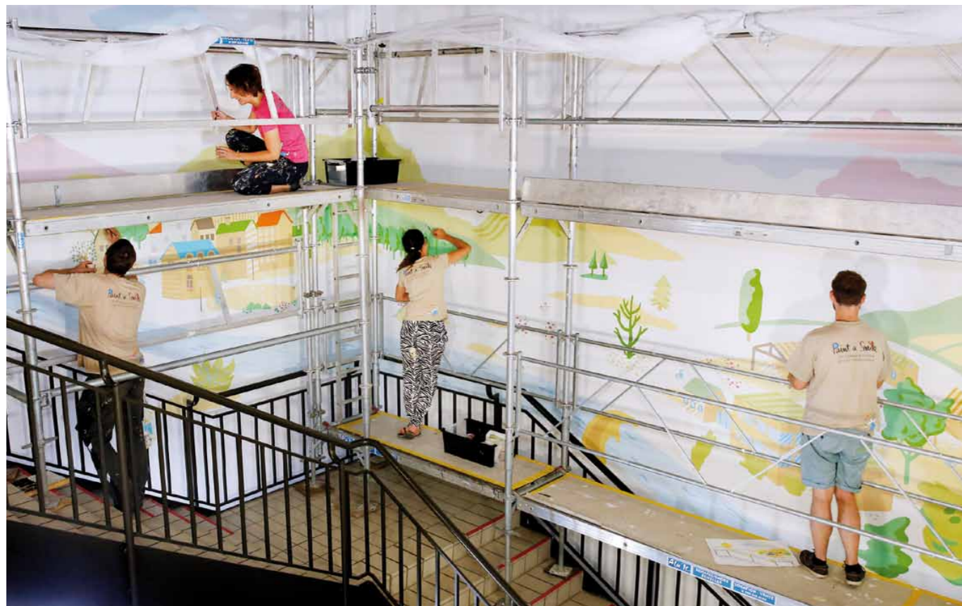
Escalier entre le RDC et le RDJ : scène principale du projet en cours de réalisation
